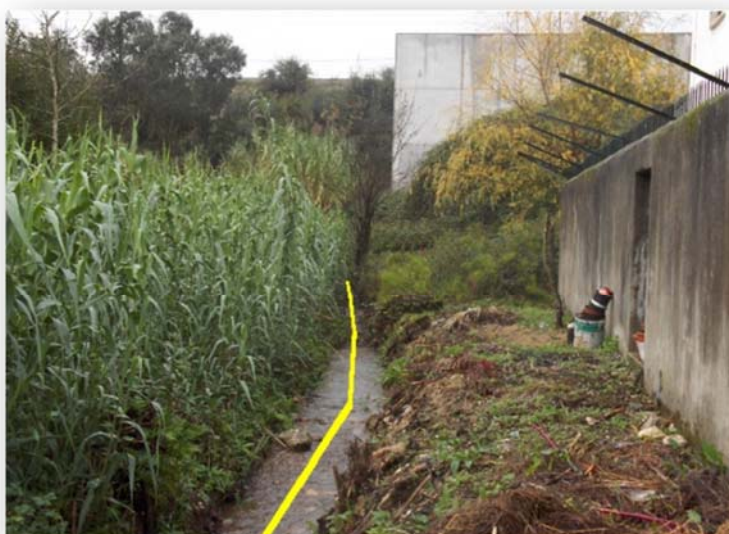
Figura 18 - Prédios delimitados junto a canal ou vala
