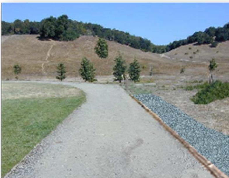
Figura 7 - Via rodoviária em zona plana
