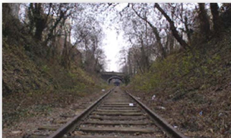
Figura 13 - Via ferroviária em zona com declive
