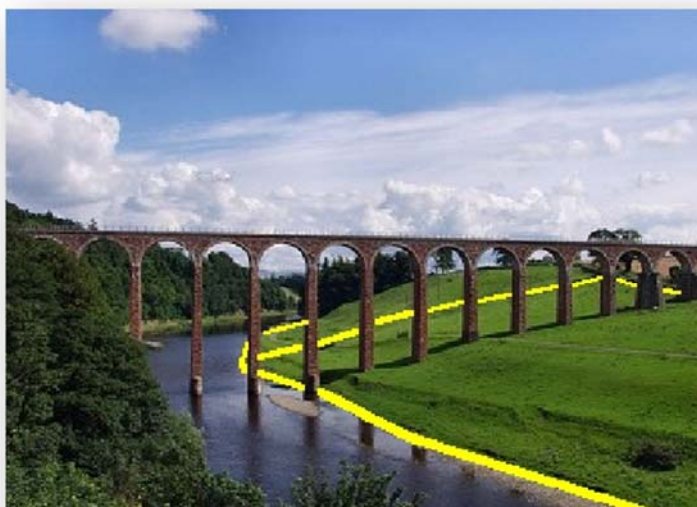
Figura 35 - Prédio delimitado sob obra de arte
