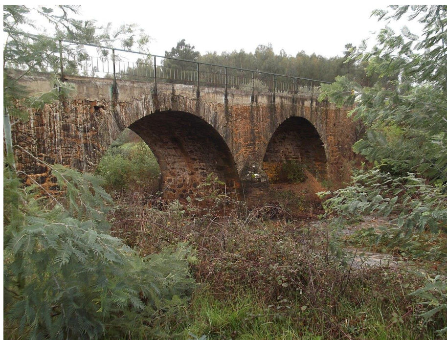
Figura 21. Ponte Romana sobre a Ribeira do Castelo
