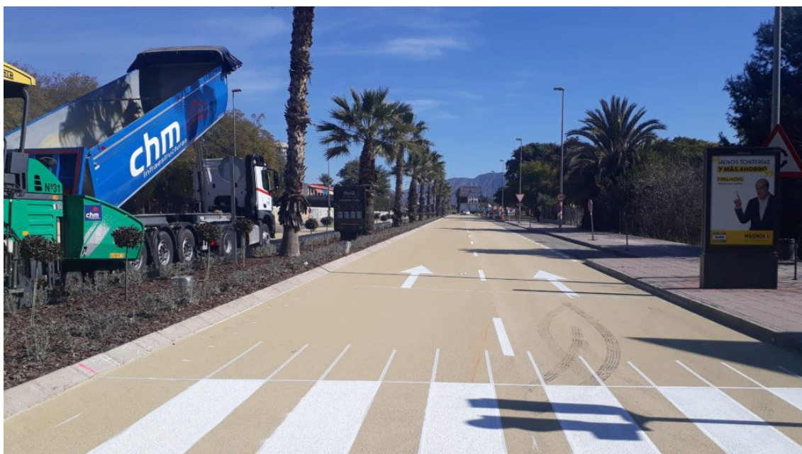
Figura 10 – Troço de uma estrada pavimentada com o material inovador testado pelo LIFE HEATLAND em Múrcia. Fonte: https://heatlandlife.eu/recursos/multimedia/
