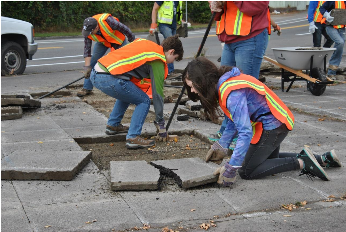
Figura 1 - Reversão da impermeabilização do solo em Pierce County, Washington. Fonte: https://www.flickr.com/photos/132714403@N02/46093120691
