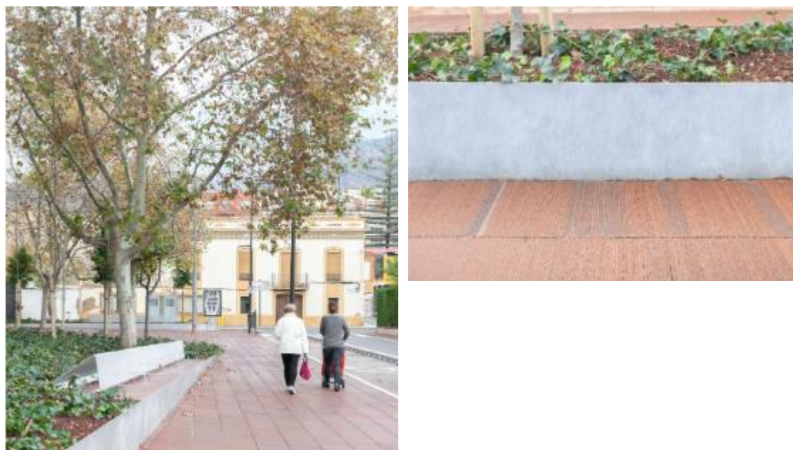
Figura 9 – Imagens do projeto piloto de colocação de pavimento permeável cerâmico numa rua de tráfego ligeiro e pedonal. Fonte: https://www.lifecersuds.eu/es/demostrador
