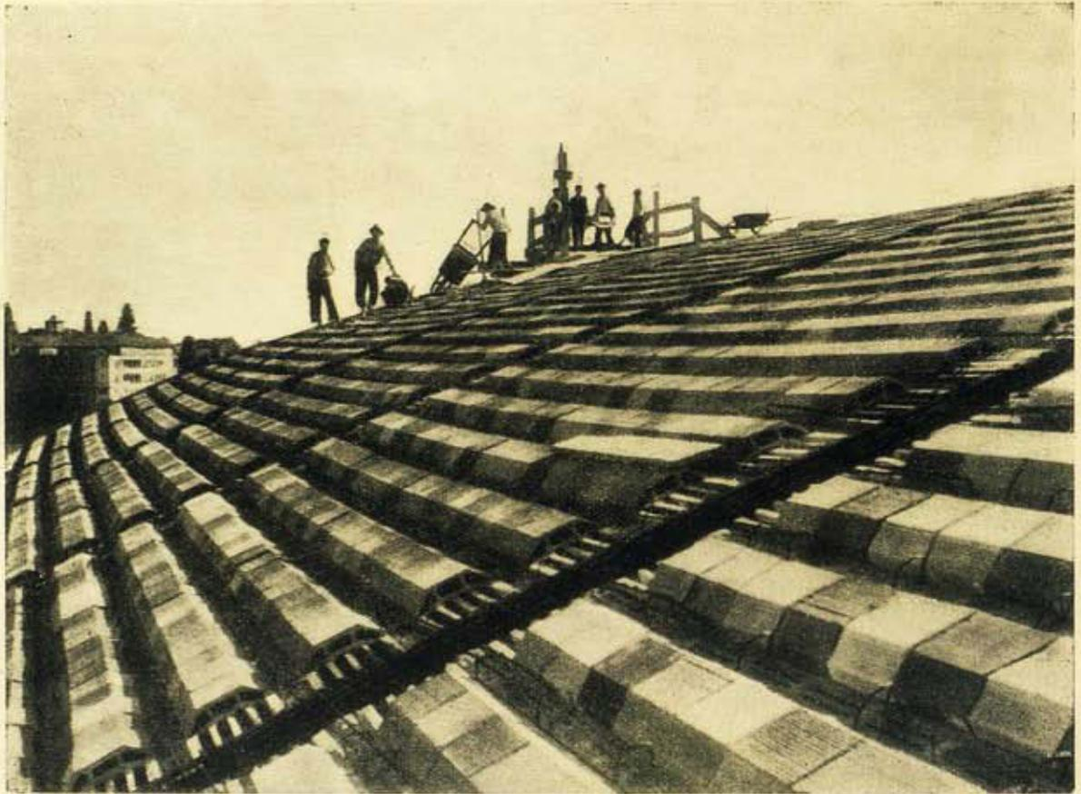
Fig. 2 — Aplicação de pranchas cerâmicas numa cobertura
