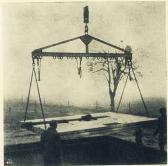
Fig. 38 — Colocação de uma placa oca de pavimento. Na placa uma abertura rectangular para encaixe das chaminés.
