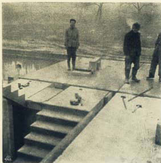
Fig. 41 — Vista parcial do piso do r/c. A zona central do patim intermédio assenta nas zonas laterais do mesmo, e que vêm fundidas com os lanços.
