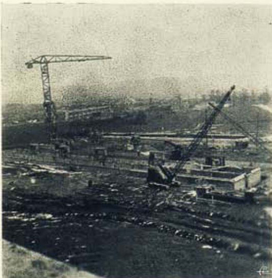
Fig. 30 — Aspecto de um bloco em início de construção, até ao tecto da cave.
