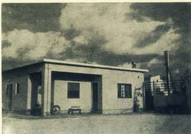
Fig. 15 — PORT SAINT LOUIS DU RHONE — Habitação do guarda e arrecadação.
