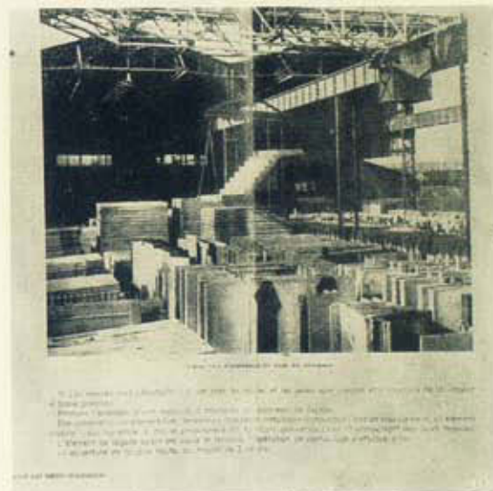
Fig. 20 — Um aspecto do depósito. Ao fundo a zona de fundição, coberta. Cada elemento é movimentado e colocado em posição idêntica à da sua utilização em obra.
