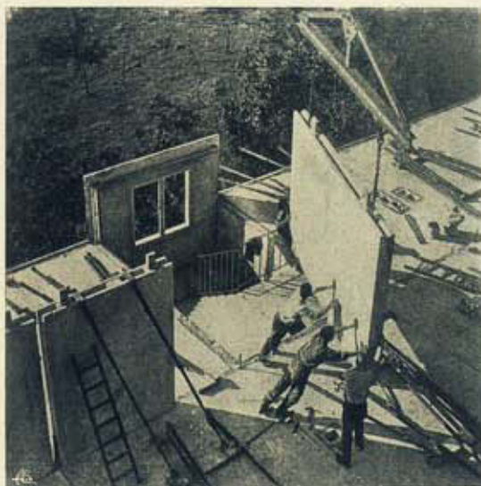
Fig. 51 — Colocação de um elemento vertical longitudinal. Ver espigões. Ver escoramento. O corrimão da escada é aparafusado para o que na moldagem se contaram com os respectivos orifícios. Vê-se aqui como ficam as peças das chaminés correspondentes à espessura do pavimento.
