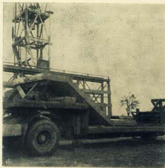
Fig. 22 — Camião para transporte dos elementos. Uma escada em posição igual à que ocupará na obra. Armação para segurar elementos verticais.
