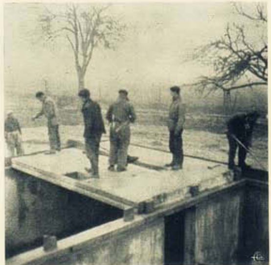
Fig. 40 — Colocação de uma placa oca de pavimento. Na placa uma abertura rectangular para encaixe das chaminés. Ver rasgos na placa e armaduras para betonagem com uma cinta de travamento.
