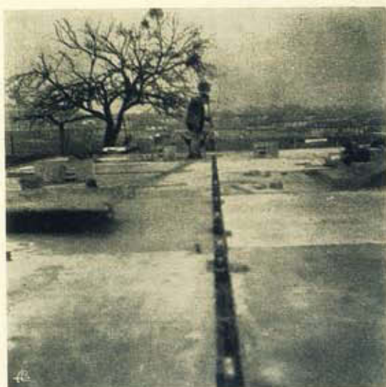
Fig. 45 — Outro aspecto antes da betonagem.
