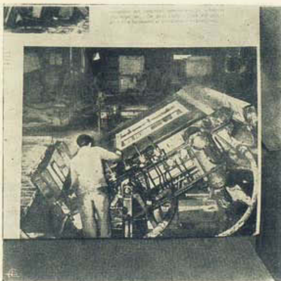
Fig. 11 — Libertação do elemento das prisões ao molde metálico.
