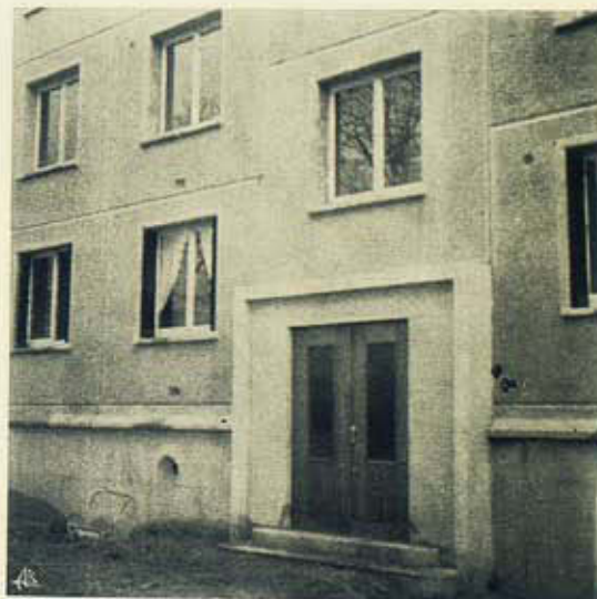
Fig. 76 — Entrada, vãos de escada, orifícios para ventilação das cozinhas.
