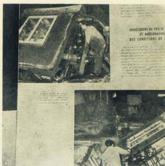
Fig. 10 — Um elemento de fachada acabado de fundir, com uma janela de madeira, colocada no molde de fundição. Complexidade mecânica. Facilidade de desmoldagem, realizada por um só homem. Fase de basculamento.
