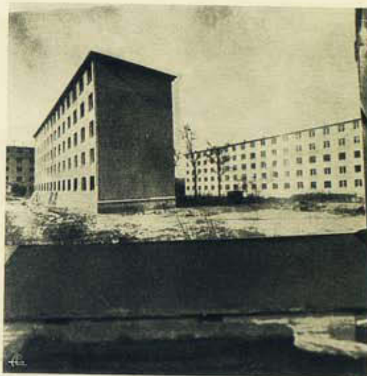
Fig. 74 — Conjunto de 110 habitações construídas na Rua Renaudel, em Rouen, executado totalmente em 6 meses.
