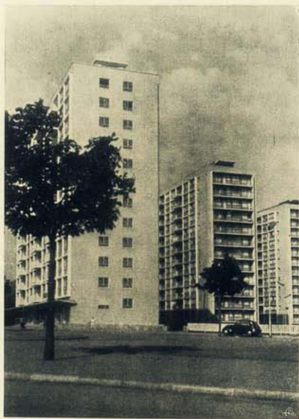
Junto à Exposição de Liège, erguem-se grandes blocos. — Obra meritória como busca da solução do problema habitacional.
