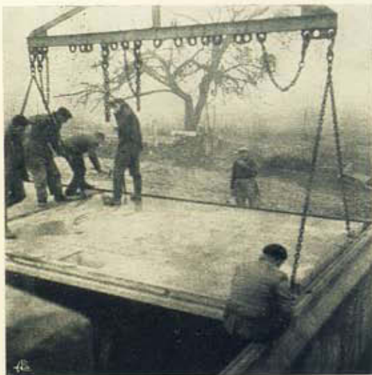
Fig. 39 — Colocação de uma placa oca de pavimento. Na placa uma abertura rectangular para encaixe das chaminés. Ver rasgos na placa e armaduras para betonagem com uma cinta de travamento.
