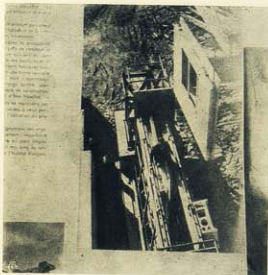
Fig. 23 — Carga de um elemento de fachada. O camião em baixo já com um elemento de chaminé.
