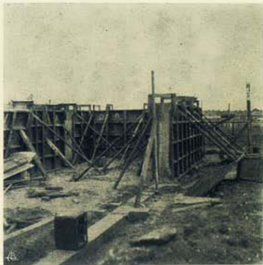
Fig. 28 — Moldes metálicos das paredes da cave. Escoras de madeira.
