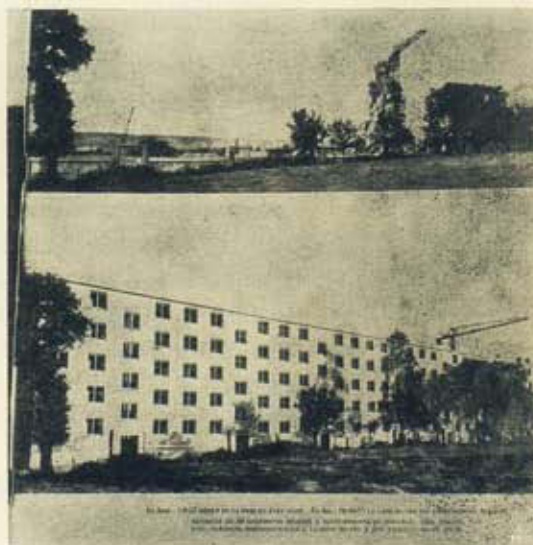
Fig. 72 — Em cima: Um bloco de 80 habitações em Saint'Etienne-du-Rouvray, em início de construção — 7-9-57. Em baixo: O mesmo bloco já em 18-10-57. Este bloco foi elevado em 40 dias.
