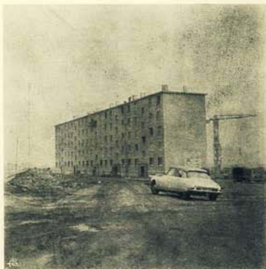
Fig. 69 — O mesmo bloco. Terraço. Chaminés.
