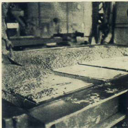
Fig. 4 — 2. a betonagem de um elemento vazado — ver cofragem a desperdiçar e armaduras das vigotas.
