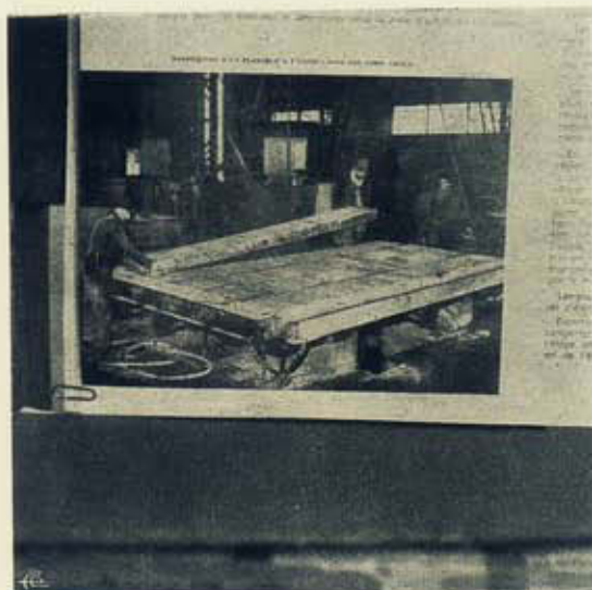
Fig. 3 — Colocação de cofragem de madeira a perder para a formação de ocos — ver as armaduras servindo de vigotas.
