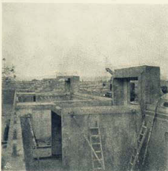
Fig. 35 — Outra fase da obra.
