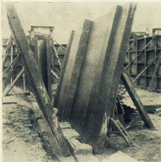
Fig. 27 — Paredes da cave com elementos de betão fabricados no local, com moldes metálicos. (Ver dentes de encaixe).
