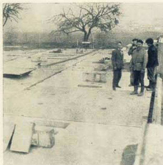
Fig. 43 — Um aspecto do piso do r/c com as aberturas rectangulares das chaminés, orifícios para tubagens de esgotos e peças das chaminés correspondentes à espessura dos pisos. Cada troço da chaminé é sustentado pela peça correspondente à espessura do piso. Ver os intervalos entre as placas, que vão ser betonados e alguns com armaduras de travamento. Ver a idade dos operários.
