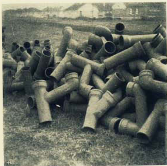
Fig. 59 — Manilhas de fibrocimento para esgotos.
