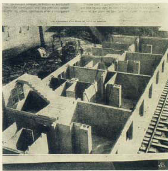
Fig. 36 — Outra fase da montagem dos elementos. Ver condutas para as chaminés de cozinha e para o aquecimento, tudo pré-fabricado. Na parede da direita notam-se as extremidades superiores das armaduras dos pilares de ligação dos elementos verticais, cuja betonagem se efectua no local. Ver a modulação da construção.
