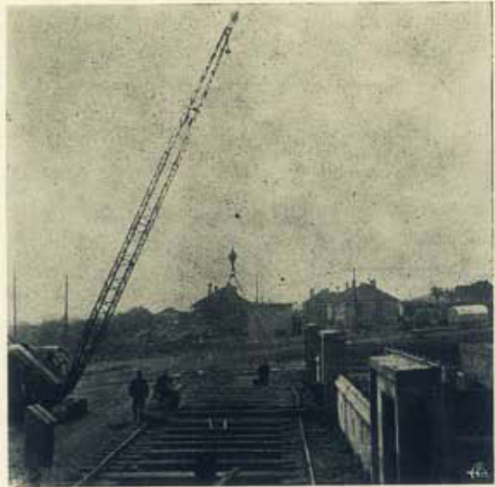
Fig. 30 — Montagem da via férrea com troços pré-fabricados, para ponte rolante. A grua aqui em serviço desloca-se por meio de lagartas. A direita, entradas para os prédios.
