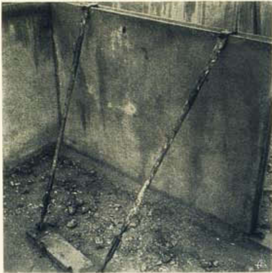
Fig. 29 — Aprumo das paredes com escoras-tirantes extensivas. Ver rebaixo superior e lateral para encaixe de outros elementos.
