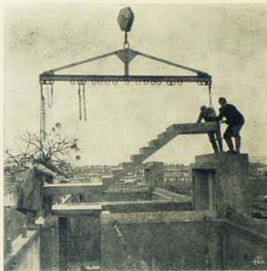
Fig. 34 — Colocação do 2.º lanço de escada do prédio, entre o piso do r/c e o patim intermédio antes do r/c. Ver os espigões no cimo da parede longitudinal da cave a meio da profundidade do prédio para encaixe das peças superiores.
