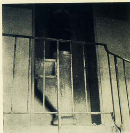
Fig. 60 — Conduta de lixos, situada a meio do patim da escada. Na porta de um lado a caixa para a ligação eléctrica. Do outro a ligação da água.
