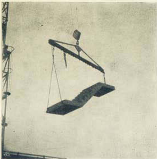
Fig. 33 — Colocação de uma escada.
