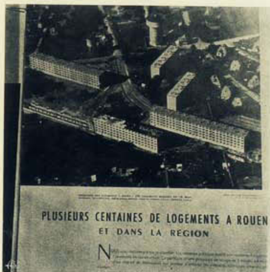
Fig. 75 — Vista de um conjunto de 280 habitações realizado em 10 meses, em Rouen (operação canadiana).
