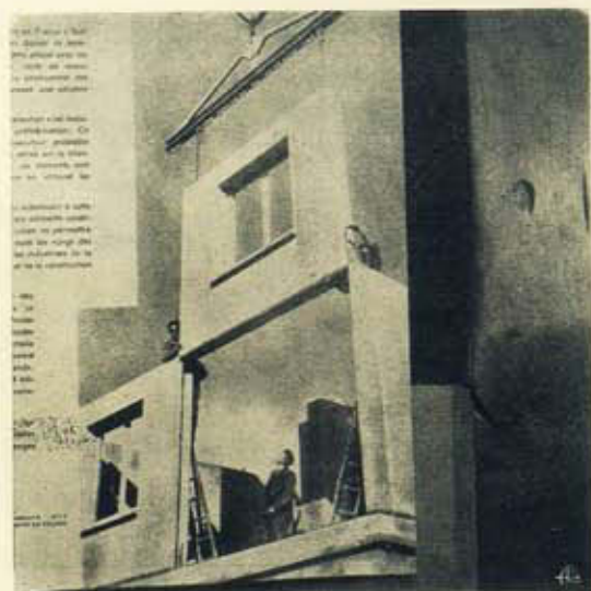
Fig. 47 — Colocação de um elemento de fachada.
