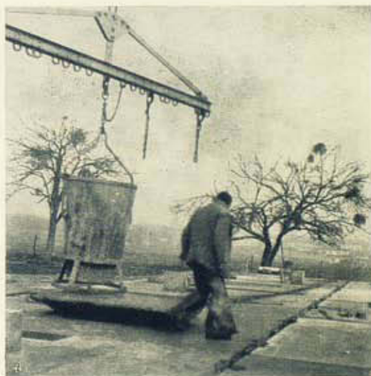
Fig. 44 — Vai começar a betonagem dos intervalos dos elementos. Alguns varões longitudinais e outros verticais, são colocados antes da betonagem.
