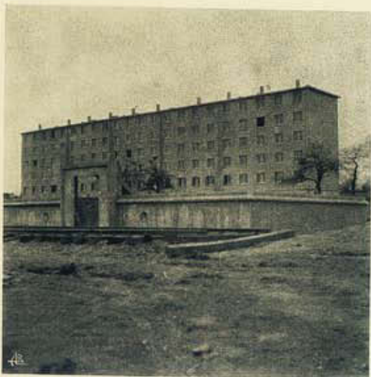
Fig. 73 — Um bloco já construído e outro em início.
