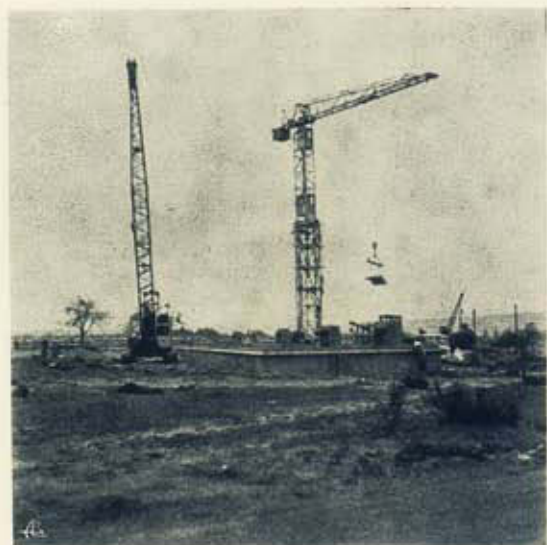
Fig. 31 — Colocação de uma escada.
