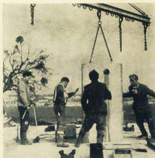
Fig. 46 — Colocação de um troço de chaminé. Ver início da fuga.
