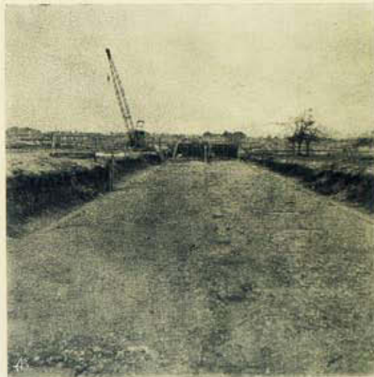
Fig. 26 — O terreno após o enchimento das fundações com betão fresco. Ver pequenos dentes para encaixe das paredes.
