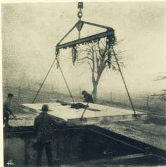
Fig. 37 — Colocação de uma placa oca de pavimento. Na placa uma abertura rectangular para encaixe das chaminés.
