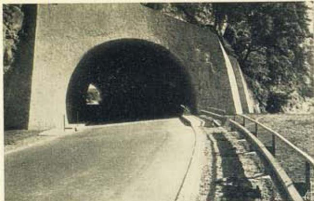
Túnel em acabamento na estrada de Salzburgo a Badgastein, construído para substituir um troço da estrada (à direita) com más curvas, apresentando um grupo escultórico na parede da entrada.
