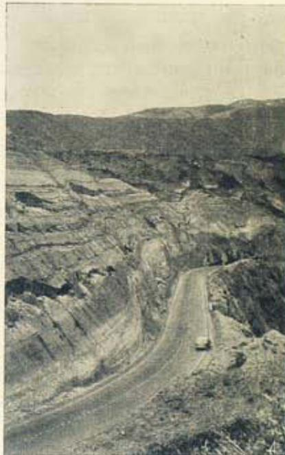
Zona da estrada das Furnas (Açores) lançada em terreno extremamente difícil, onde só não se projectou um túnel, com admirável vista panorâmica, por os tufo vulcânicos serem muito pouco coerentes e susceptíveis de provocarem perigosos escorregamentos
