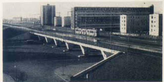
Fig. 12 - Uma das auto-estradas sem cruzamentos em Slo-tervaart, Amesterdão-oeste. As vias dos eléctricos estão separadas das vias de rodagem. O viaduto transpõe 103 m.
