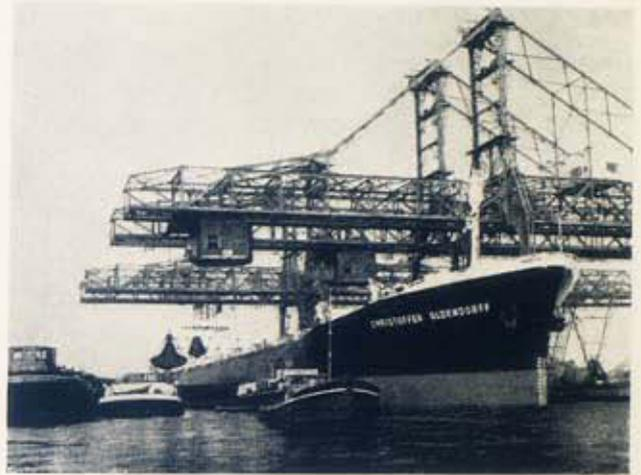
Fig. 7 - Ponte de carga para minério a granel
