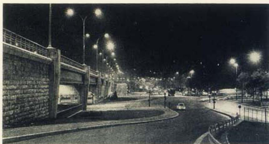
**Fig. 1 - Boulevard périphérique l'Echaugeur de la porte de Pantin.** Le boulevard périphérique franchit la porte de Pantin par un viaduc au dessous duquel un passage souterrain pour voitures assure une liaison continue avec les boulevards militaires. La réduction des emprises de voirie résultant de la superposition de ces deux ouvrages construits en même temps a permis de transformer en zones d'arbres et de pelouses les surfaces importantes ainsi récupérées
