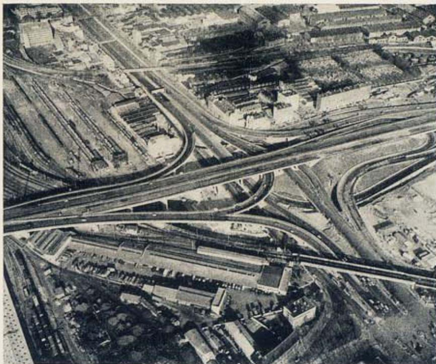
Fig. 5 - L'Echangeur de la porte de la Chapelle. Cet échangeur, de caractère exceptionnel, comprend douze ponts ou viaducs indépendants, à tablier en béton précontraint. Ses chaussées ont une superficie de 70 000 m<sup>2</sup>, dont 31 800 sur ouvrages. Pour les isoler les unes des autres et atténuer les dénivellations en les rendant progressives et naturelles, 8700 arbres de haute tige et 18 000 m<sup>2</sup> de gazon ont été plantés sur de vastes mouvements de terre
