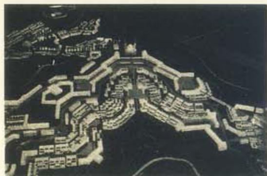
Fig. 17 La pente assez forte de ce piton conduit à cinq échelons de quartiers, reliés par des voies de corniche. Les mouvements de terrains concaves et convexes ont permis de remarquables arrangements, combinés avec les différences de niveau.
