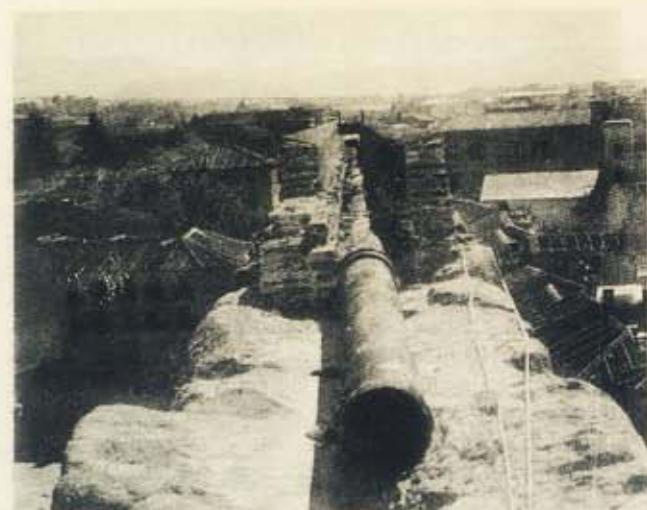
Las losas primitivas de coronación, con los muretes sobrepuertos y tuberías, durante las obras de saneamiento, derribo y desmontaje. Junio 1970.
