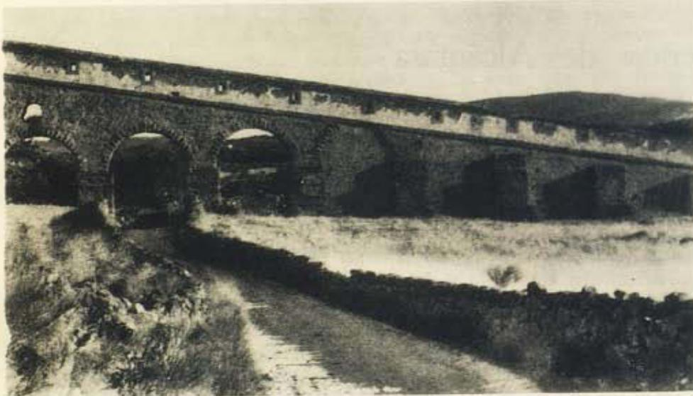
Vista frontal de la zona de fábricas romanas: el remate en pendiente corresponde a la galería visitable de la tubería del sifón.
