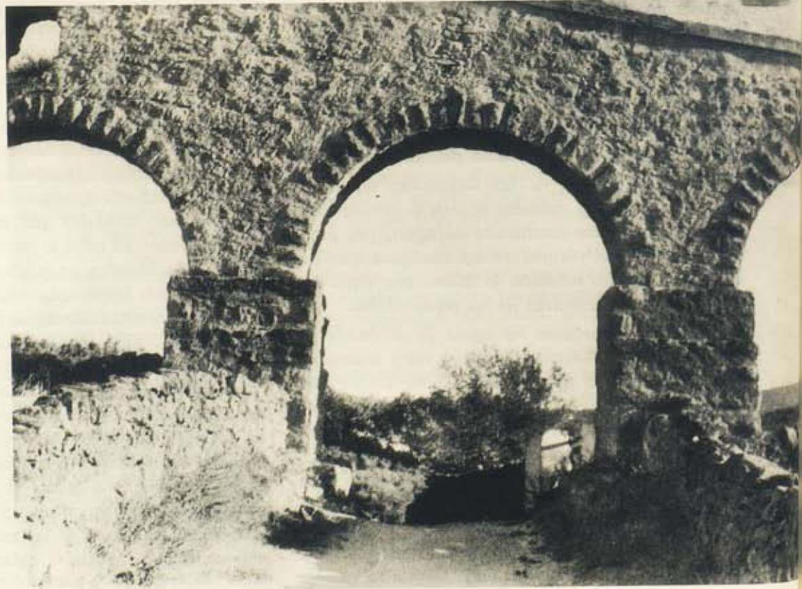
Vista de tres de las arquadas originales: se aprecian las boquillas con dovelas bien apañadas y con almohadillado en saliente cilíndrico.
