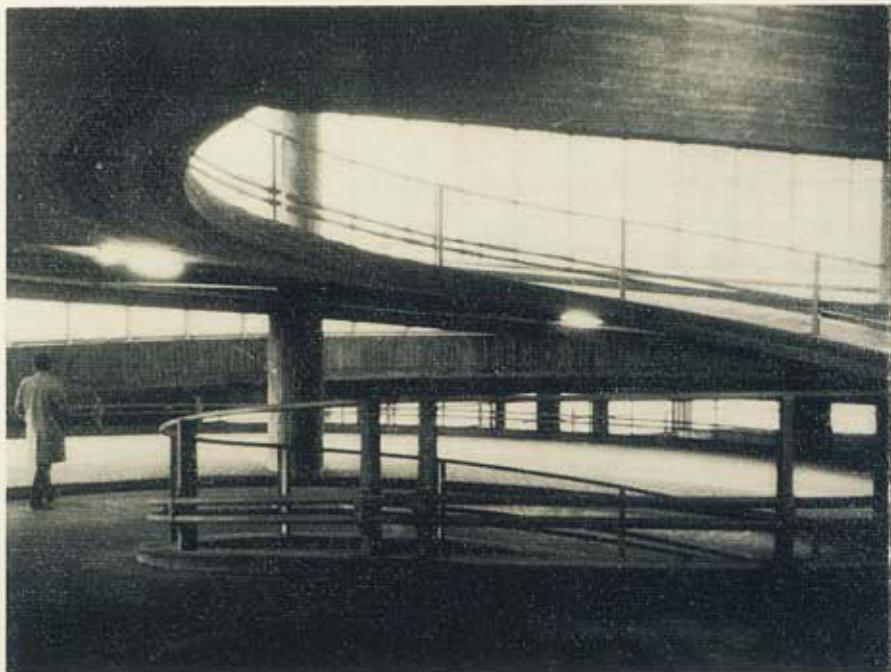
Foto 5.1 — Rampa helicoidal de duplo sentido com separador. Rotterdam.
