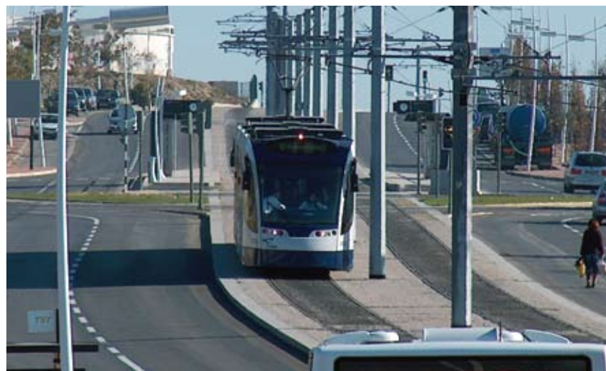
Ferrovia ligeira em canal dedicado
