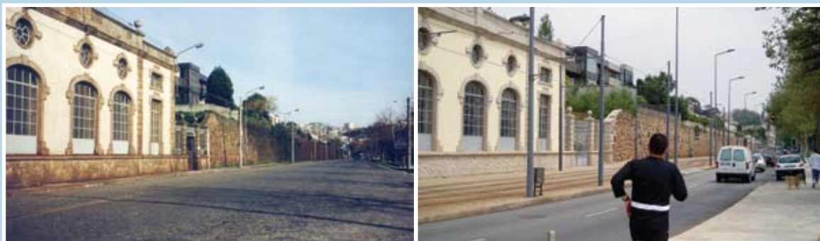
Espaço canal antes e depois da intervenção
